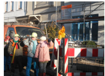
Buchenstraße: Baustelle - Lärm und Dreck (7)
