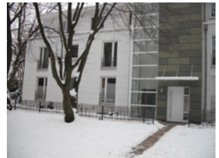
Neubau auf ehemaliger Wiese: Arensburgstraße (2)
